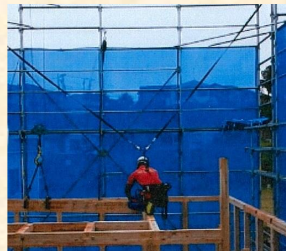
ダブル安全ブロックとフルハーネスによる上棟
