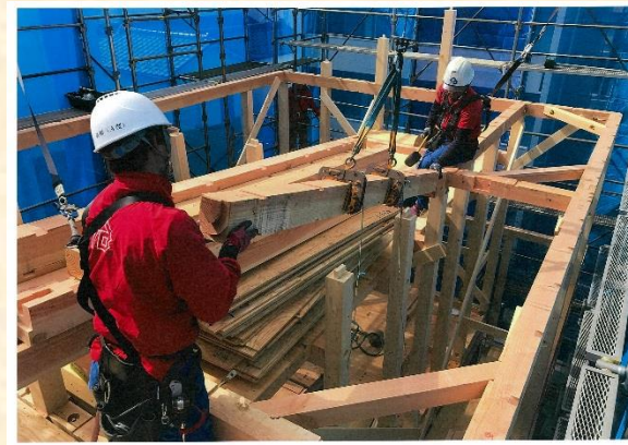
安全ブロックとフルハーネスによる上棟
