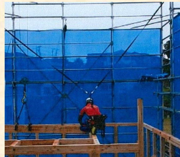
スライドレール安全ブロック工法による上棟
